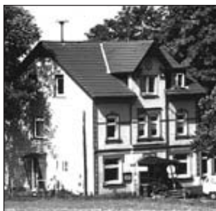
Gefährdetenhilfe „Kurswechsel“, Wohngemeinschaft 1
